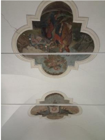
Risse im Kreuzgewölbe und an der Aussenfassade
