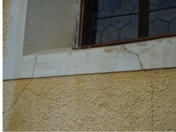
Risse im Kreuzgewölbe und an der Aussenfassade
